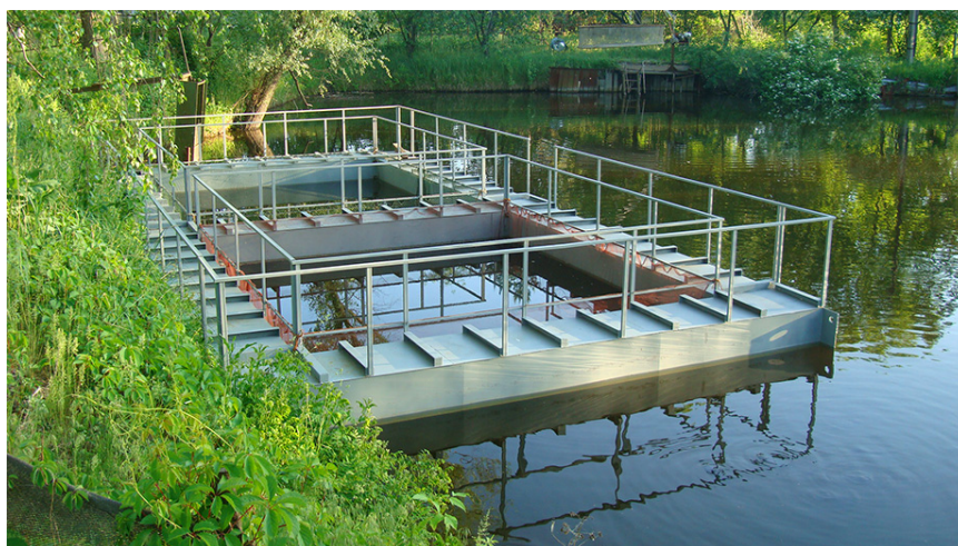
Рис. 3. Эстакада для установки стационарных садков (источник: http://www.5692.com.ua/article/634987 )
